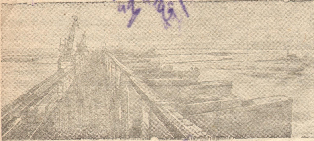
Волгодонстрой. На строительстве Цимлянского гидроузла. С начала Цимлянского водохранилища уровень Дона около плотины поднимается все выше и выше. На снимке: общий вид плотины. Справа — заполняющееся донской водой Цимлянское водохранилище. Прессклише ТАСС.
